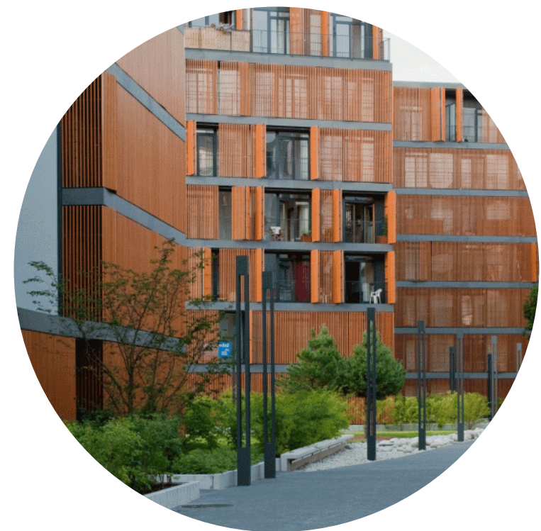
Tårn på rekke 7-8 etasjer Wilanowska, Warszawa JEMS Architektci
