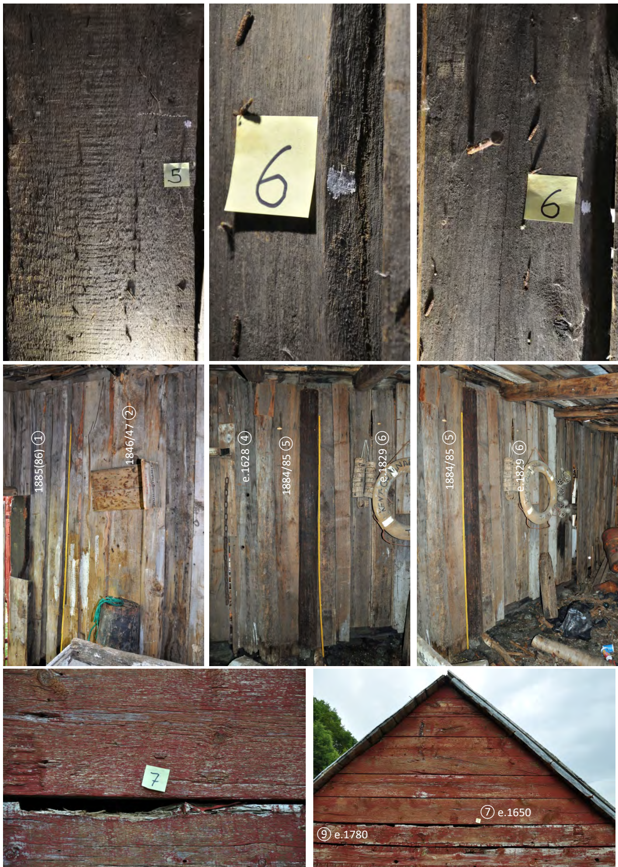
Figur 8c: Prøveuttak. Oversikts- og nærbilder av stokkene Kvn001-kvn007 med dateringene. I midten: Tidligere ytterside av nordveggen, nå i tilbygget.
