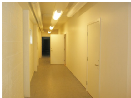
Bilde 12 Rømningskorridor i ny garderobe og VIP del.
