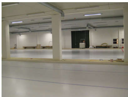
Bilde 25 Rømningsutganger fra isflaten.
