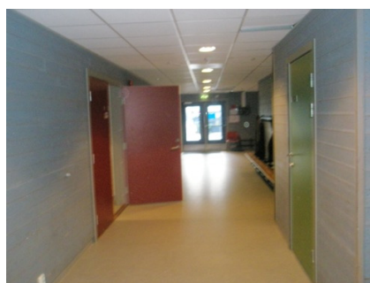
Bilde 13 Trekledning i rømningskorridor fra gymsal.
