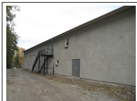
Bilde 8 Utvendig rømningstrapp i ubeskyttet stål
