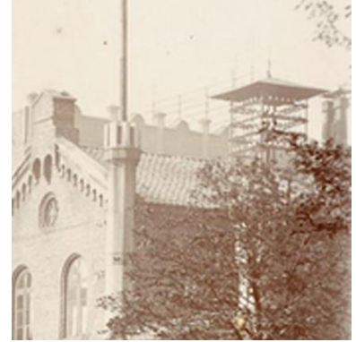
Figur 78 Utsnitt av bilde fra 1903 med utkikkspost for brannvakt. Ukjent fotograf, Oslobilder.no
