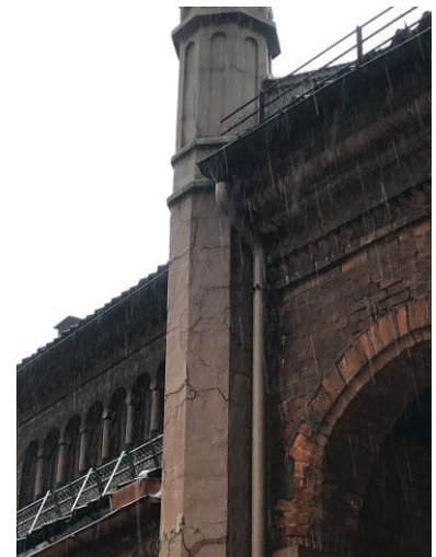
Figur 41 Omfattende skader på fialer.
