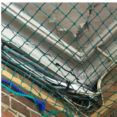
Figur 98 Åpen kabelforlegning.
