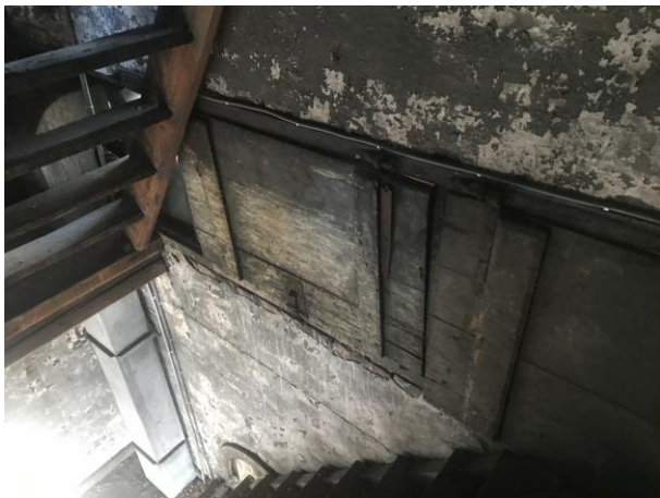
Figur 80 Originale lemmer i øvre del av tårn.
