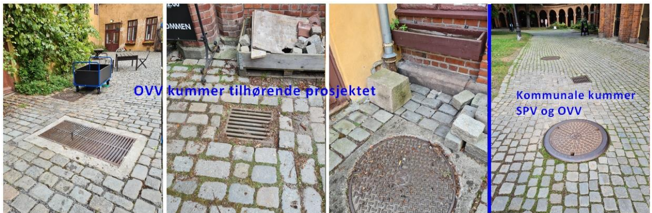
Figur 103 Overvannskummer, samt kommunale samlekkummer for overvann og spillvann fra kirken og kirkeristen
