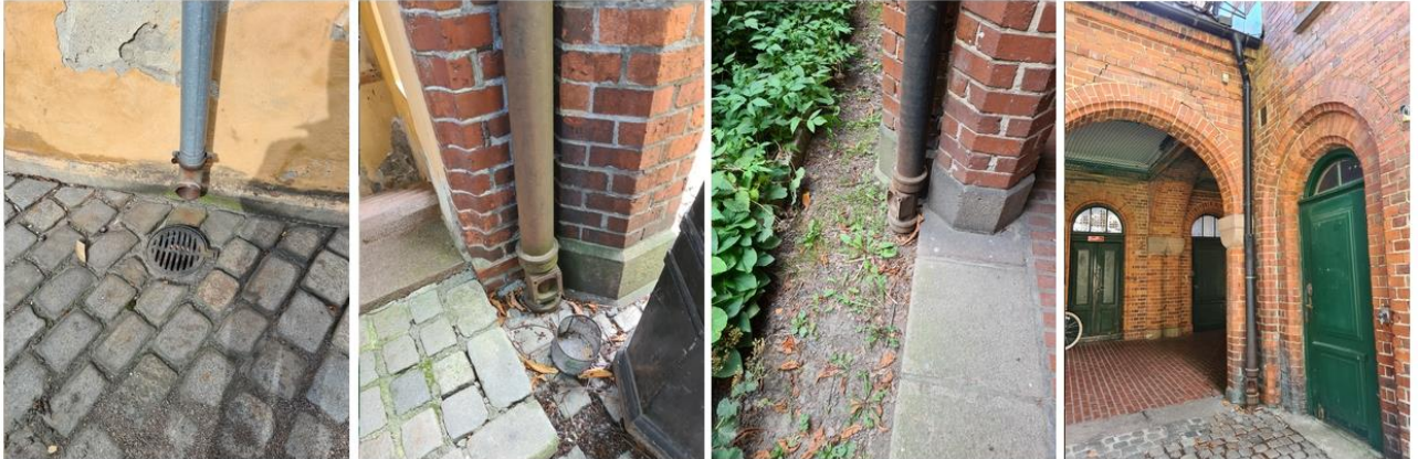
Figur 102 Taknedløp ført til eks OV ledning tilknyttet kum for fellesuttrekk til Dronningens gate
