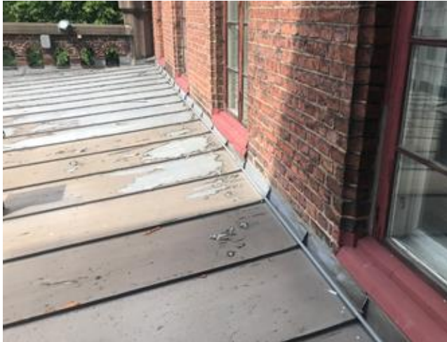
Bilde 5 Bilde fra befaring 05.08.2020 – tak over kaldtloft ved Domkirkekontoret
