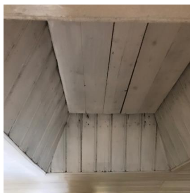
Figur 74 Original åpning til overlys 1.08.
