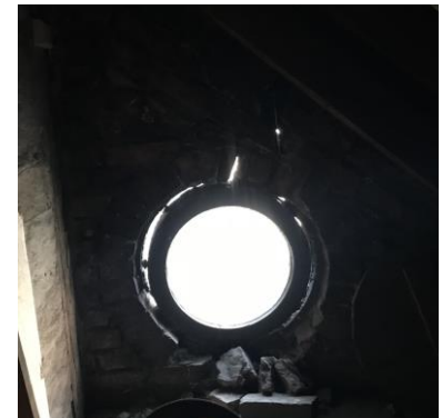
Figur 63 Setningsskade.
