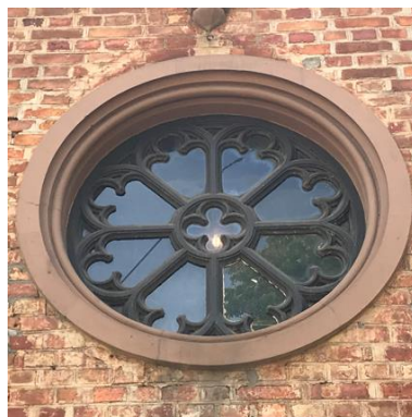
Figur 56 Originalt vindu gavl mot Nord.
