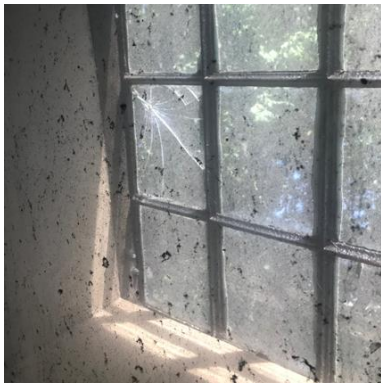
Figur 72 Typisk originalt overlys med nedføring.
