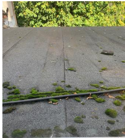
Bilde 1 Bilde fra befaring 08.09.2020 – tak over kaldtloft på Domkirkekontoret
