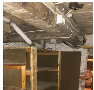
Figur 96 Åpen Kabelforlegning, Y.B.K.40-46.
