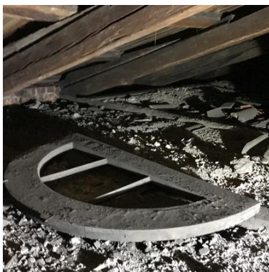
Figur 73 Originalt overfelt fra indre buegang.
