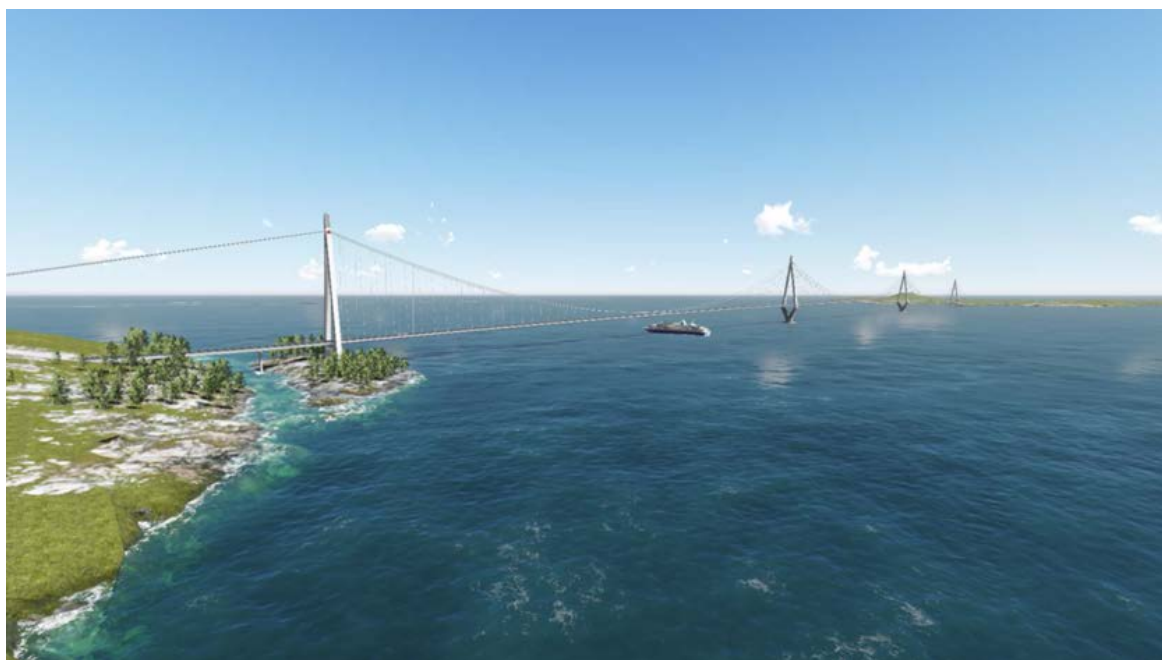
Figur 28 Fleirspenna hengebru med tårn på flytarar
